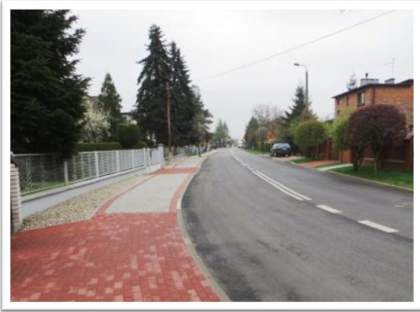
Remont ul. Karłowicza dz. Północ
