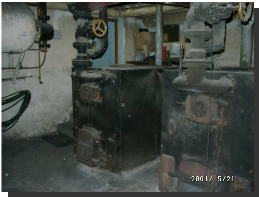
Kotłownia przed modernizacją
